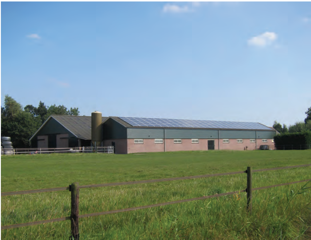
Stal met zonnepanelen in de Lopikerwaard, vrijwel heel dakvlak, goed in het dakvlak geïntegreerd
